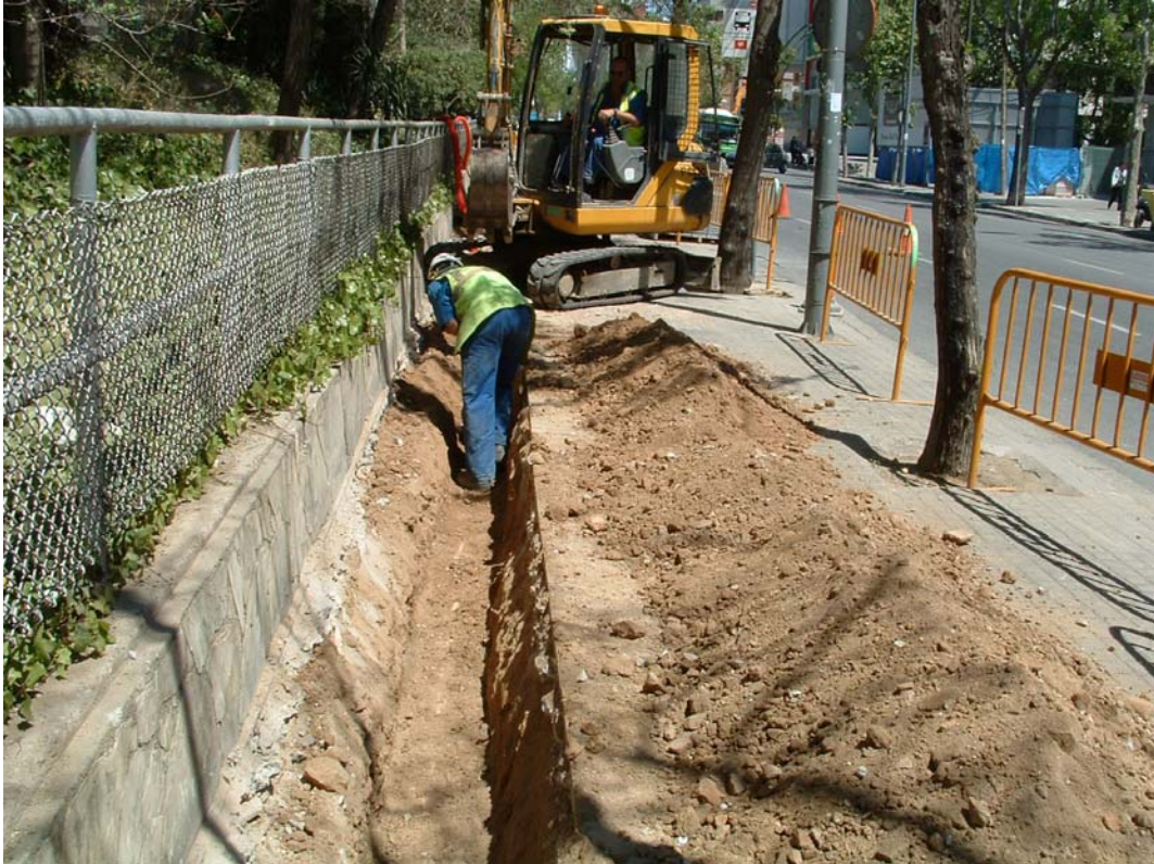
FOTOGRAFIA 8→ Imatge parcial de les tasques d'obertura de la rasa a l'alçada del núm.73 de la Travessera de les Corts.
