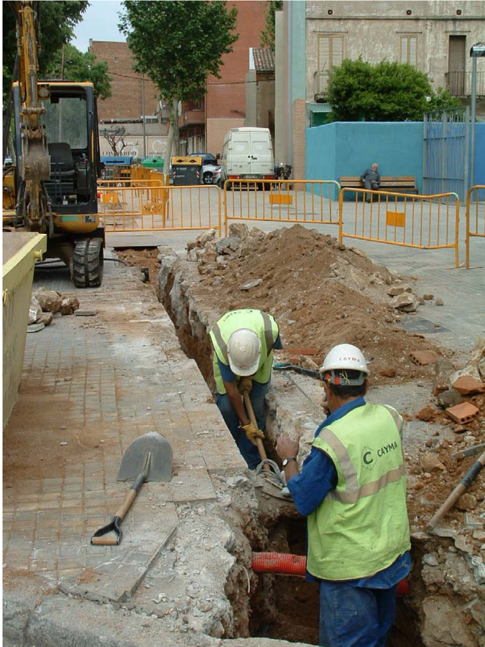
FOTOGRAFIA 10→ Fotografia de l'últim tram (Travessera de les Corts, 60B-68), durant les tasques d'obertura de la rasa.
