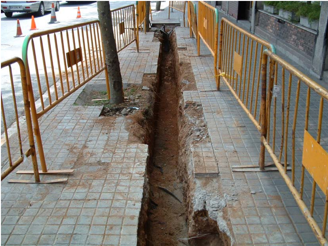
FOTOGRAFIA 9→ Vista del tram final de la rasa a la banda nord de la Travessera de les Corts, a l'alçada del núm..63-65.
