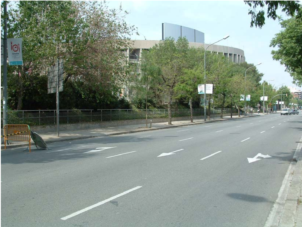
FOTOGRAFIA 1→ Imatge general de situació de la zona de la intervenció arqueològica corresponent a la Travessera de les Corts, 73-129.
