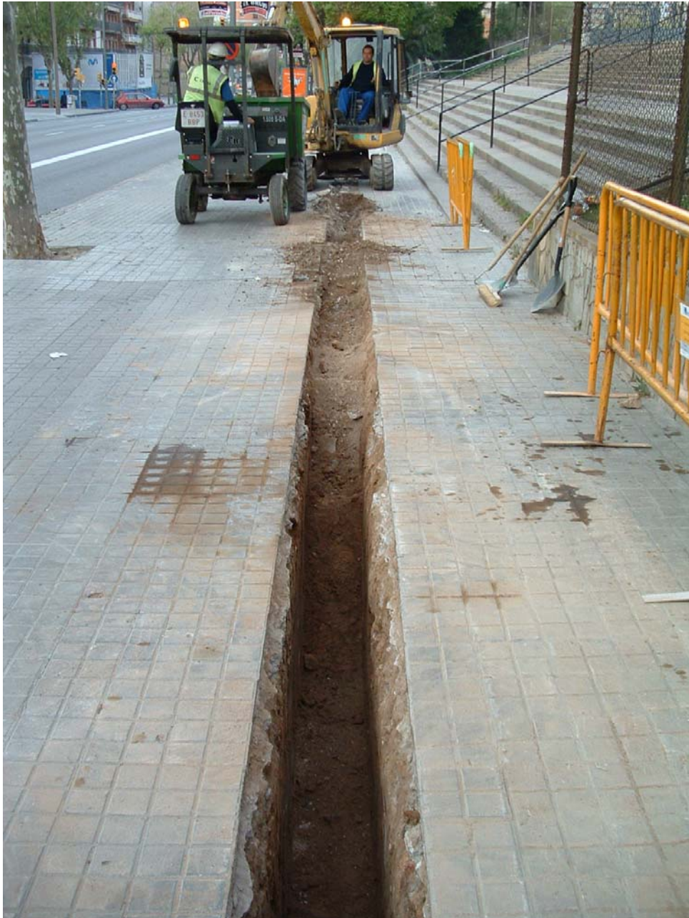
FOTOGRAFIA 7→ Imatge de l'obertura de la rasa de FECSA, on observem les dimensions d'aquesta.
