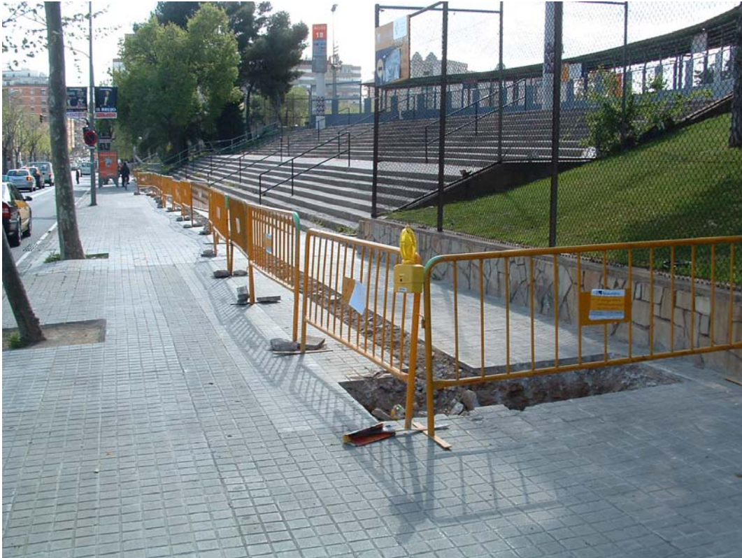
FOTOGRAFIA 5→ Vista del primer tram de la intervenció (a l'alçada del núm. 129 de la Travessera de les Corts) just quan es començava l'obra.
